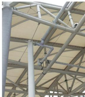
图5 钢柱雨水立管顶部连接实景
