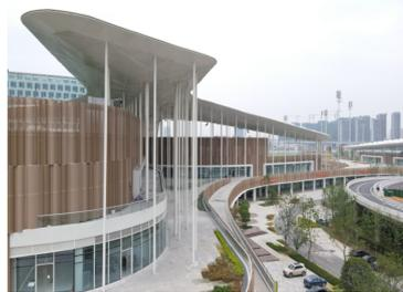
图4 项目结构柱、装饰柱、钢柱雨水管实景
